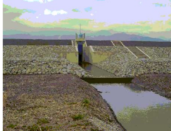
小江排水樋管
