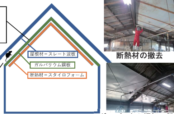
ガルバリウム鋼板の設置
