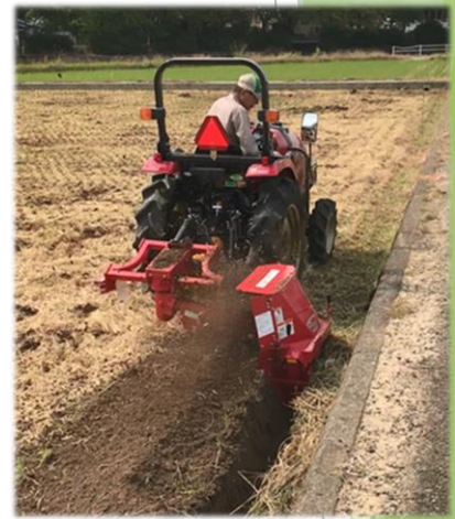
写真 額縁明渠施工の様子 (トラクタ+リターンデッチャ)
