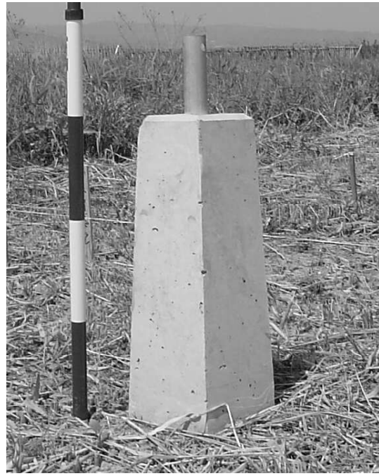
コンクリート基礎
