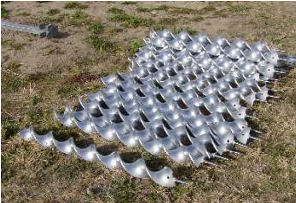
②スパイラル杭基礎打ち込み
