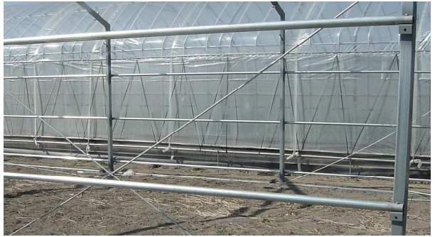
⑦ビニペット設置
