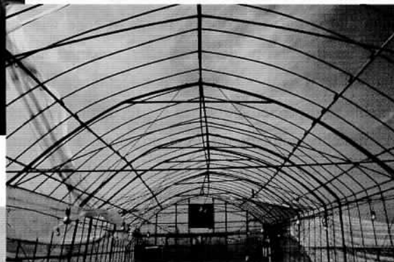
左：妻面から被害始まる (9/17 17時撮影, 17時の最大瞬間風速44m/s)
