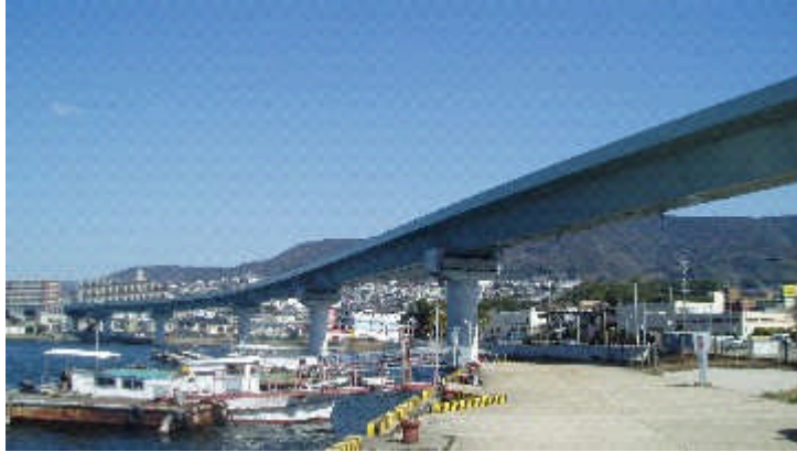
建設中の西九州自動車道
