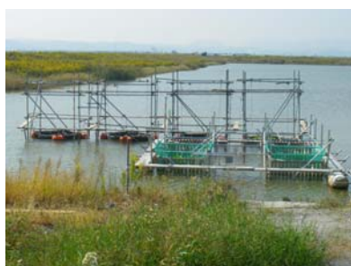
写真 2 木柵及びメソコスムの設置状況
