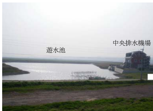
写真 1 遊水池及び排水機場
