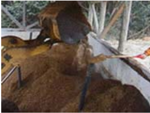
写真 1.3.17 通気管の埋設
