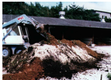
写真1.2.5 石灰の混合事例
