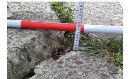
天端被覆において約10cmのクラックが発生。また、縦方向に7cmの沈下。
