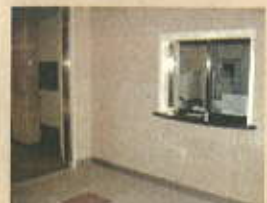
出入りする人を確認できる位置、高さに窓を配置した管理人室
