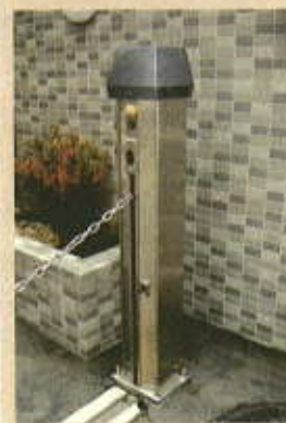
駐車場出入口に設置されたオートバリカー
