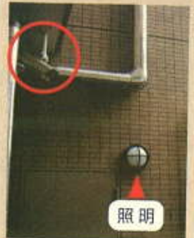
周囲からの見通しが確保されていない場所に設置された防犯カメラ（一般型）
