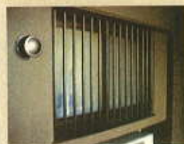
共用廊下に面した腰高窓の面格子
