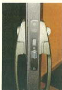
防犯仕様様の玄関扉 (扉の外側パネルが少し伸び、扉と扉枠の隙間を隠す)
