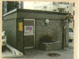
周囲からの見通しが確保され照明設備、施錠可能な扉が設けられたゴミ置場
