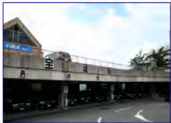
公用車車庫(第一車庫)
