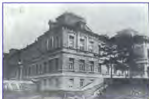
長崎港から見た県庁舎
