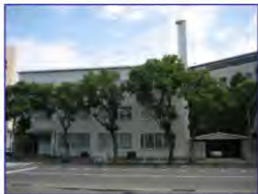
第二別館（昭和34年建設）
