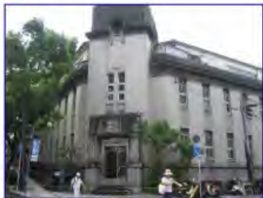
第三別館（大正12年建設）
