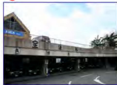
公用車車庫（昭和55年建設）
