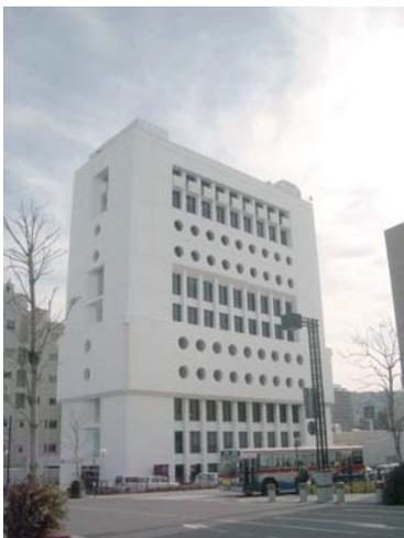
○建物の中段にある2層の壁の部分にジャイアントフレームを設置することで耐震性を増す工夫。
