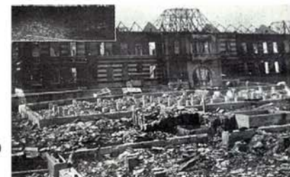
■原爆で消失した県庁舎
