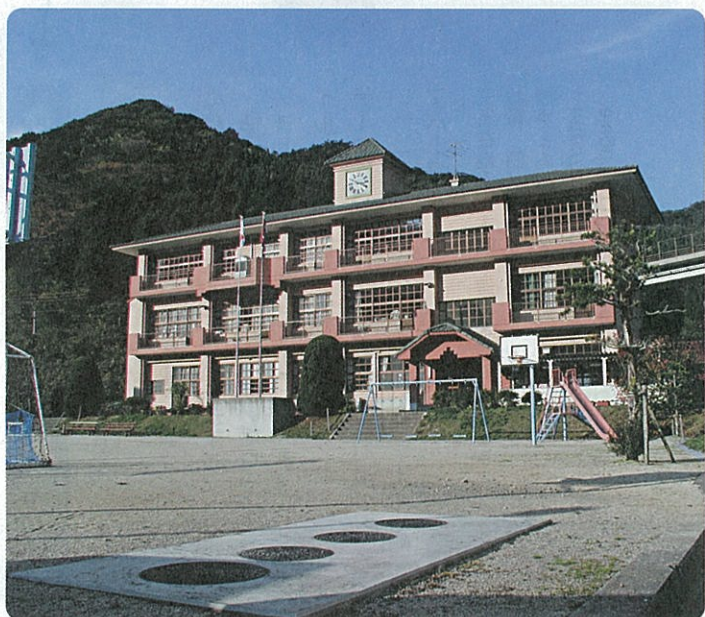
大村市立黒木小学校、手前のマンホールが「高度処理型浄化槽」
