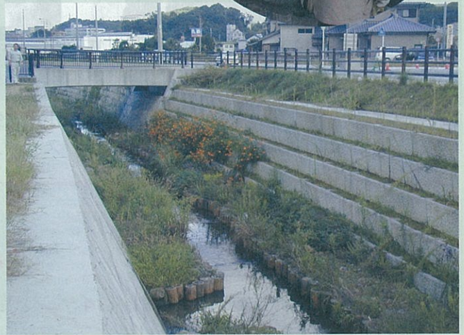
間伐材を利用した河川工事 喜々津川水系中里川(諫早市)
