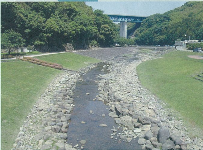
親水性のある河川公園として整備された江の串川 (東彼杵町)
