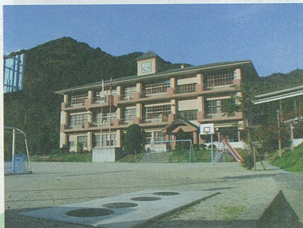
大村湾に汚れた水を流さないように下水道や浄化そうなどを整備しています。 (大村市立黒木小学校、手前のマンホールが高度処理型浄化そう)
