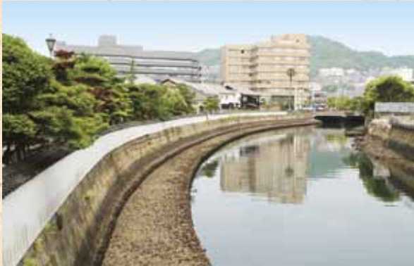
中島川変流工事跡
