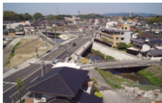
日野川河川改修(総合流域防災事業) 佐世保市 河川改修が進んだことにより、下部の浸水被害の軽減が図られました。
