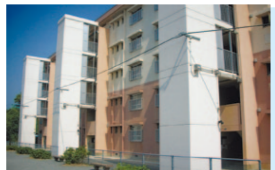
県営住宅(毛井首団地) 長崎市 エレベーター付きのバリアフリー改善工事を行うことによって、高齢者にも安心して住んでいただける住戸となりました。
