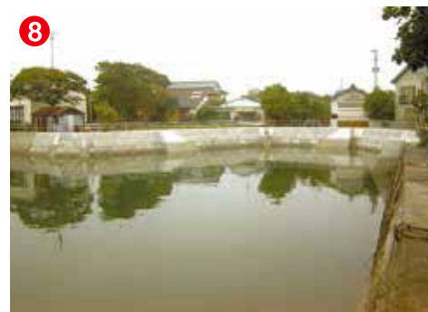
8 工事名 多比良港自然災害防止工事(護岸工) 施工者/技術者 松本建設(株)／近藤 広和 工事内容 海岸の護岸を新しくする工事です
