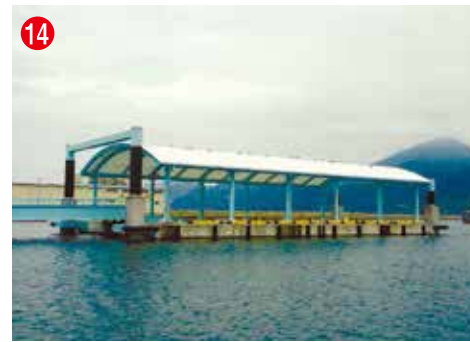
14 工事名 県北北部地区農山漁村地域整備交付金工事 (館浦漁港2工区) 施工者/技術者 (株)大島造船所長崎営業所／副島 栄二 工事内容 漁港に浮棧橋を設置する工事です
