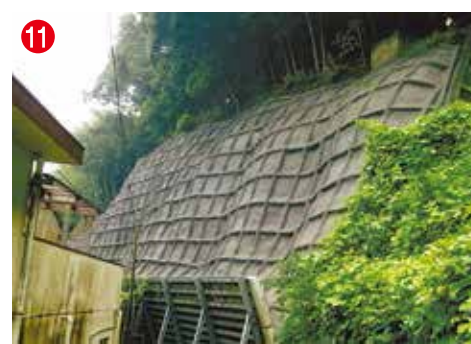
11 工事名 三川内地区予防治山工事 施工者/技術者 (株)昭大建設／河本 健一郎 工事内容 斜面を保護する工事です
