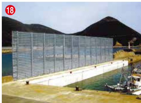
18 工事名 阿須湾地区地域自主戦略交付金 (漁村再生)工事(2工区) 施工者/技術者 (株)大川建設工業／八坂 正己 工事内容 漁港の防波堤を改良する工事です
