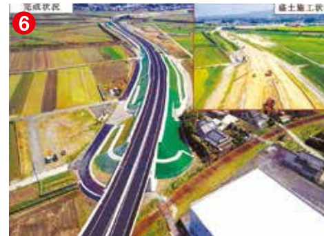
6 工事名 一般国道251号道路改良工事(盛土工6) 施工者/技術者 増崎建設(株)／山田 勉 工事内容 自動車専用道路の新設工事です
