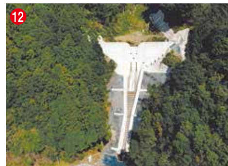
12 工事名 四郎丸前川火山砂防工事 施工者/技術者 (株)堀内組／山田 正 工事内容 土石流を防止する工事です
