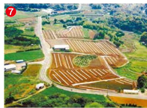
7 工事名 丸田地区区画整理事工(4工区) 施工者/技術者 (株)高谷／梅本 繁春 工事内容 農作業の効率化や収穫量向上のための工事です
