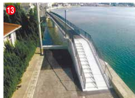
13 工事名 早岐港ふるさと輝くみんなの水辺づくり工事 (人道橋上部工) 施工者/技術者 門田建設(株)／松本 優 工事内容 港に人道橋を架ける工事です
