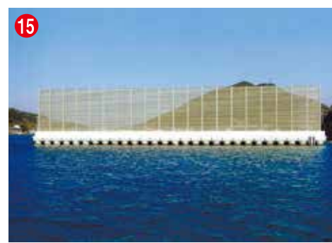
15 工事名 奈留漁港水産流通基盤整備工事(3工区) 施工者/技術者 (株)才津組／谷川 伊佐弘 工事内容 漁港の防波堤を改良する工事です
