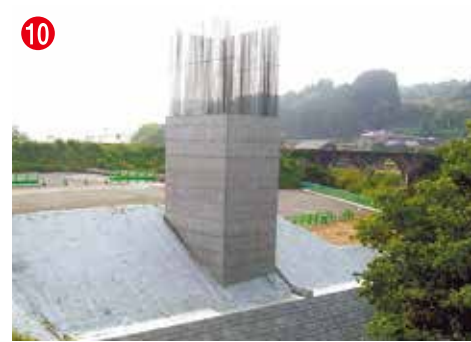
10 工事名 主要地方道佐世保吉井松浦線 橋梁整備工事(吉井1号橋下部工P5) 施工者/技術者 大坪建設(株) 県北営業所／山上 伸一 工事内容 橋を支える橋脚を新設する工事です
