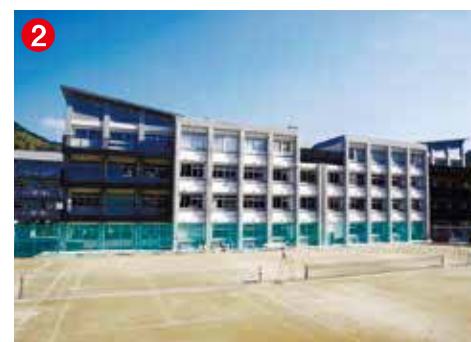
2 工事名 長崎北高校特別教室棟改築工事(2工区) 施工者/技術者 長崎大建・森美工務店JV／植木 昭 工事内容 耐震性のある校舎に改築する工事です
