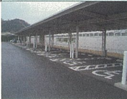
屋根付きの身体障害者用駐車スペース
