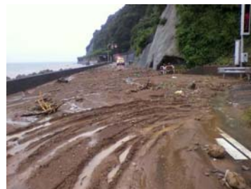
道路災害の状況（H23.6）
