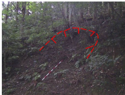
法面崩壊（自然斜面）
