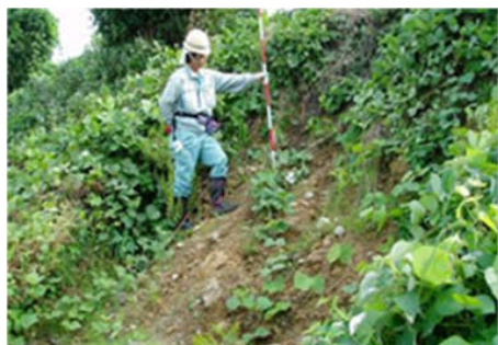
道路防災総点検（切土箇所）
