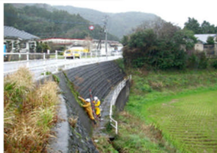
定期点検（職員による実施）
