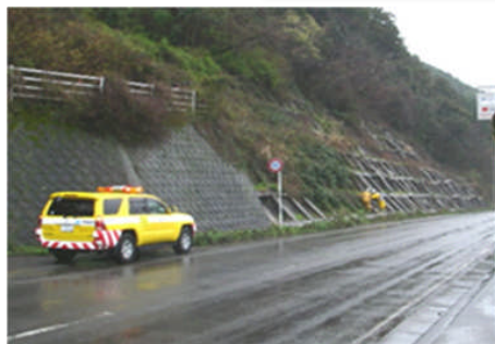
通常点検（道路パトロール）
