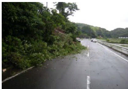
落石・崩壊 ((県)形上宮浦線 H24.6 発生)
