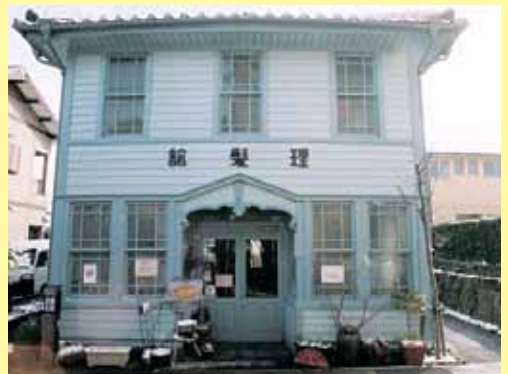
景観資産修景事例(景資第2-1号 青い理髪館(旧小林理髪館))
