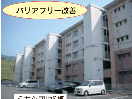
毛井首団地S棟
