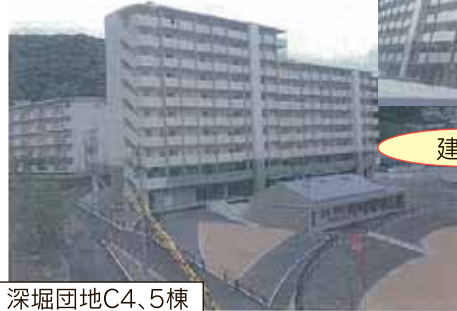
深堀団地C4、5棟
