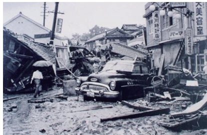
諫早大水害 (S32.7.25) の被災状況
