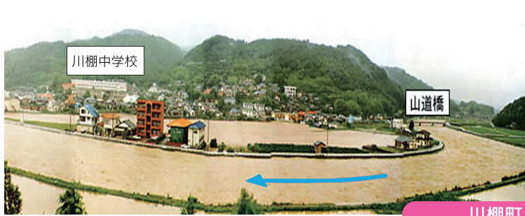
平成2年水害 (H2.7.2) の被災状況
