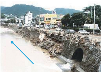
長崎大水害 (S57.7.23) の被災状況
