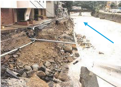
長崎大水害 (S57.7.23) の被災状況
