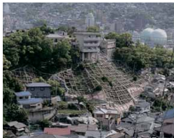
斜面上下部に張付く多くの人家を保全している法面工(長崎市)
