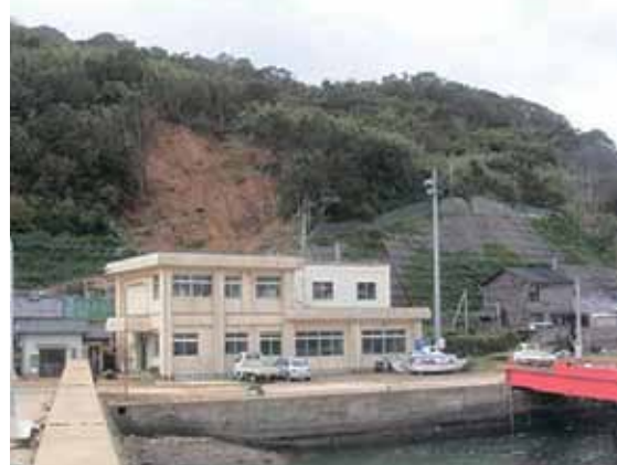
人家裏の斜面が崩壊(平成18年 五島市)
