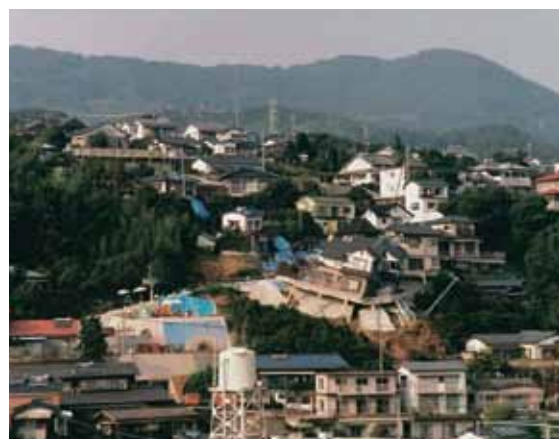
住宅密集地で発生した地すべり (平成9年 佐世保市)
