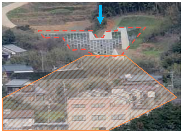
病院や人家を保全している砂防堰堤（松浦市）
