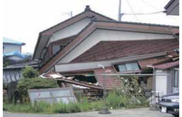
地震により倒壊した住宅
