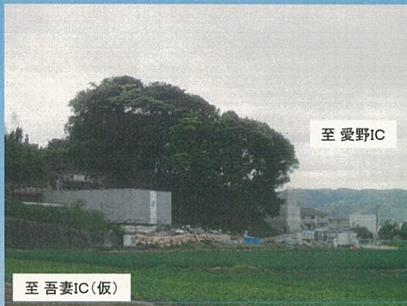
橋梁下部工施工状況(2号橋、H27.4現在)
