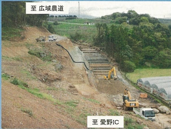
補強土壁工施工状況(吾妻IC(仮)部、H27.4現在)
