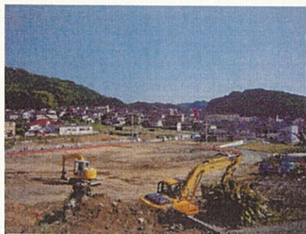
宅地完成工事施工中(元村郷)
