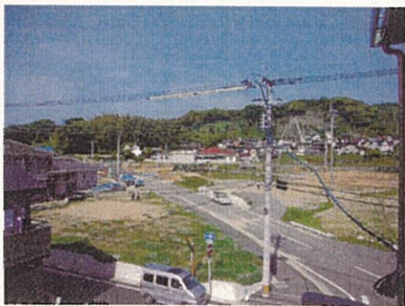
築造中の(都)西時津左底線(国道206号側)
