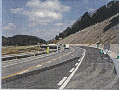
H28施工予定(終点から)
