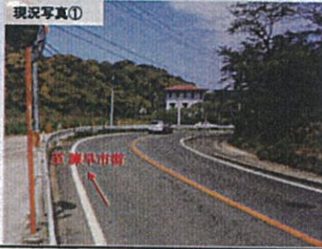
現況写真①
