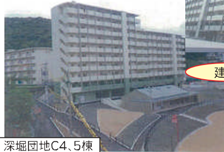
深堀団地C4、5棟
