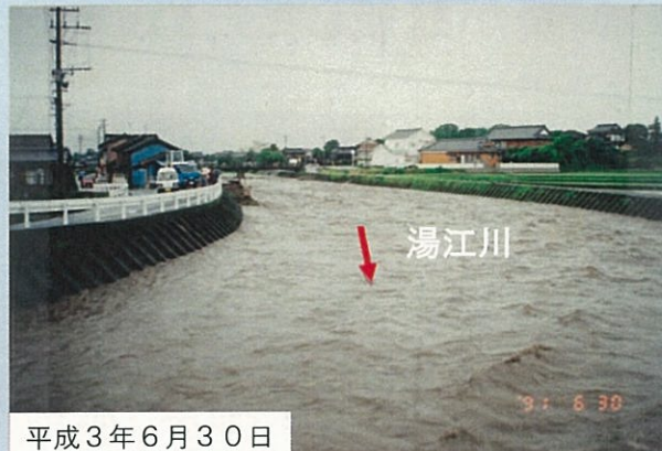
湯江川橋より上流側(1/100m付近)
