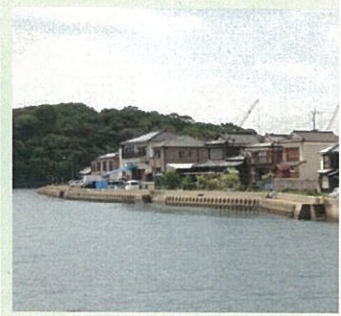
護岸(補強) L=575m
