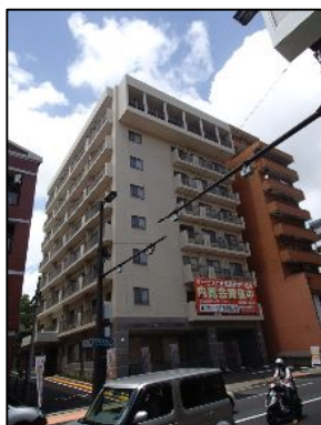
長崎市・サービス付き高齢者向け住宅
