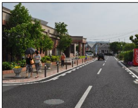
佐々町・中央地区 車道の2車線化及び歩車道の分離により、交通環境の改善及び交通安全性の向上が図られた道路。
