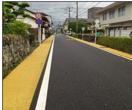
大村市・中心市街地活性化地区 電柱の片側移転や路側を利用して、歩行者等の通行空間が確保された道路。
