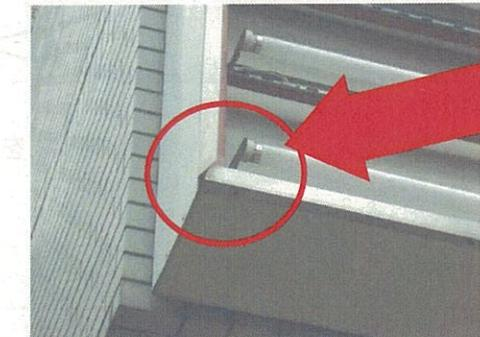
←パネルの変形、ズレ、破損の他、パネルの押さえ枠が変形し落下する場合も。
