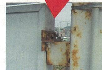
←取付金具のサビや腐食。ボルトやビス等が欠落していたら緊急の対応が必要。
