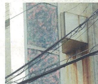
ブラケット下に汚ダレが見られると、内部の取付金具にサビや腐食の可能性がある。
