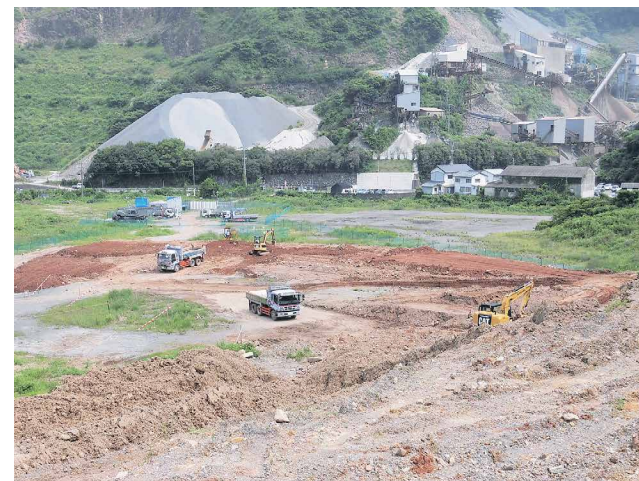
重機等による土工作業の進捗状況
