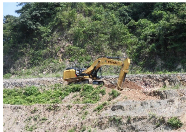
重機による切土
