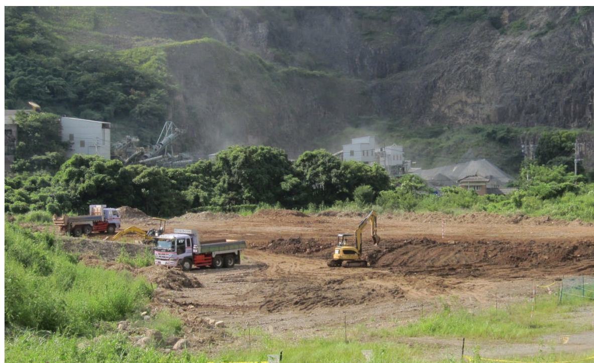
重機やダンプトラックなどを用いた切土・盛土の施工
