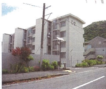
C12棟 (EV付住戸改善) 30戸
