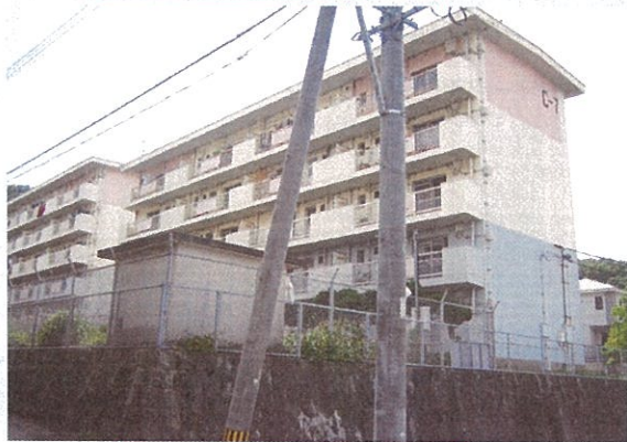
建替前C7棟
