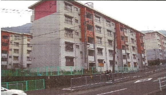
建替前C4棟
