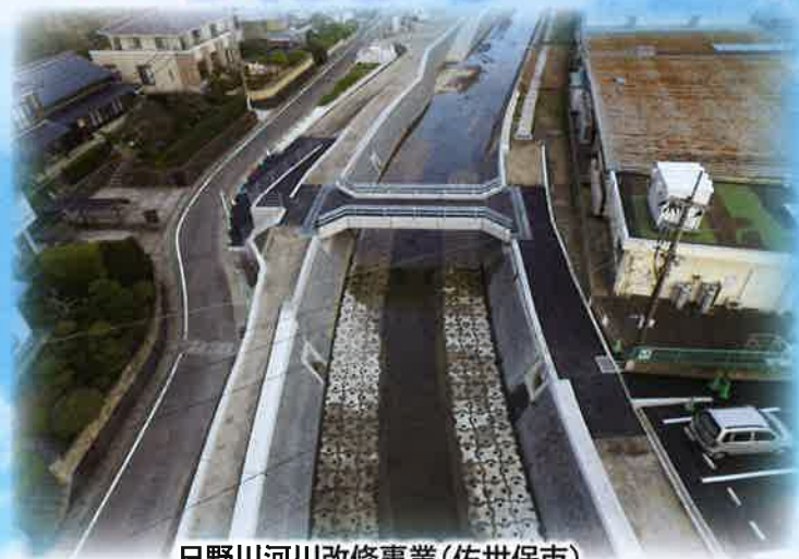
日野川河川改修事業(佐世保市)
