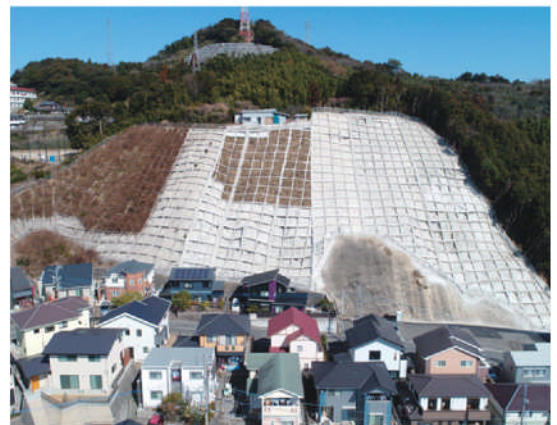
斜面下部の多くの人家を保全している法面工(長崎市)
