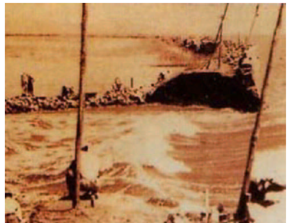
写真 1.2 破堤状況（佐賀県芦刈海岸） 昭和31年8月台風9号
