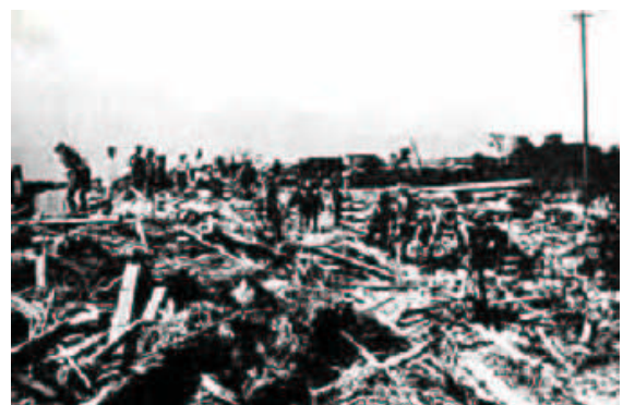
写真 1.4 高潮被害状況（熊本県熊本市沖新）
