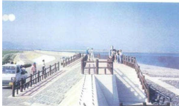
写真 1.18 展望台干潟散策路（佐賀県鹿島市）
