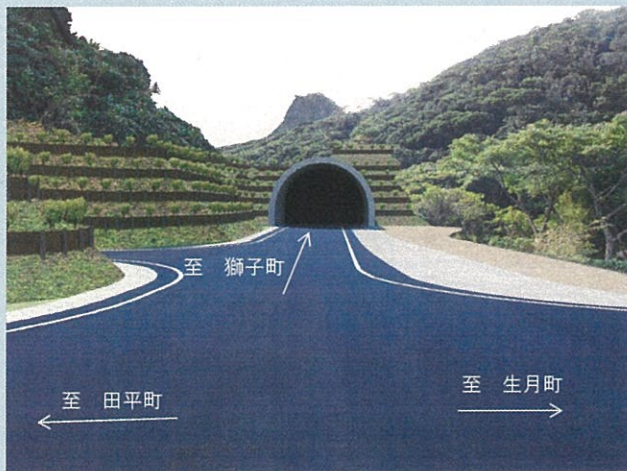
施工完了時（主師側）
