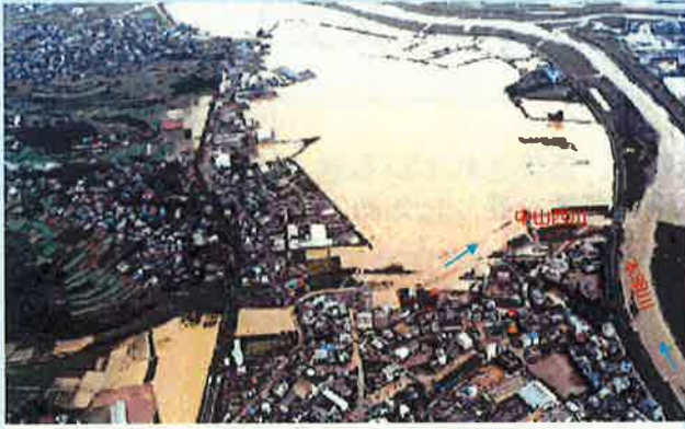
被害状況 (H11.7.23)
