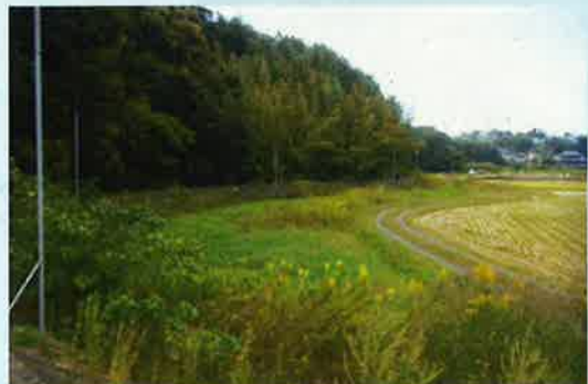
上流部改修予定区間
