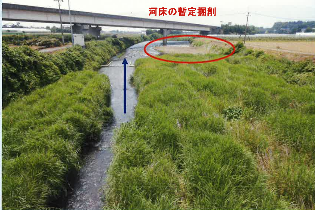
荒瀬橋下流河床掘削区間 現況写真
