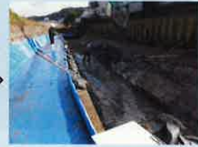
土留め工として鋼矢板の打設
