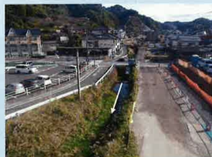
NO,72付近 (未改修)
