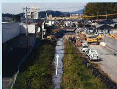
NO,68付近 (未改修)
