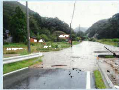
0/800m付近 市道佐保・田線 市道田大島線合流付近
