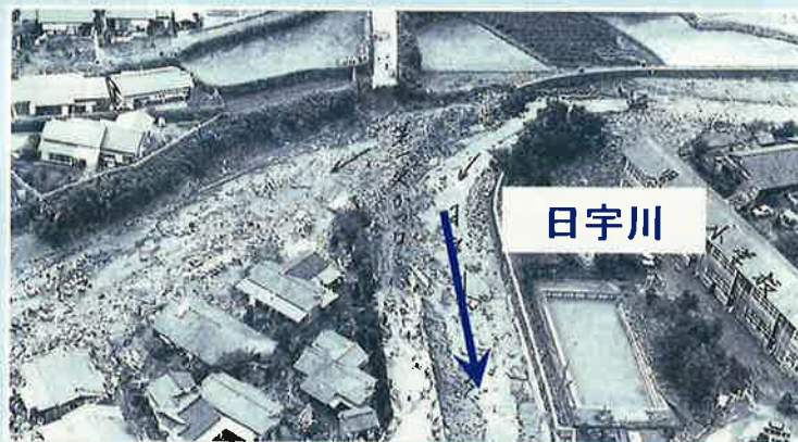
黒髪小学校付近被害状況(S42)
