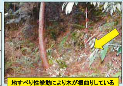
地すべり性挙動により木が根曲りしている
