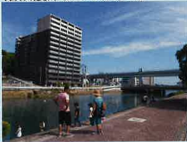
階段護岸および遊歩道
