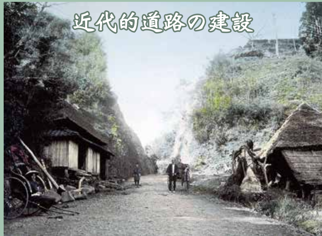
日見切通し（長崎側5.9km、日見側4.8kmの中間にあった）、道路の計画は日見新道会社であったので、開通当時、通行料を徴収した。（長崎大学附属図書館所蔵）
