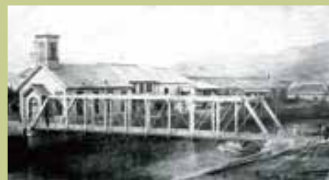
出島新橋（ブラットラス形式、木鉄混交橋、明治21年（1888）架設）（活水学院所蔵）
