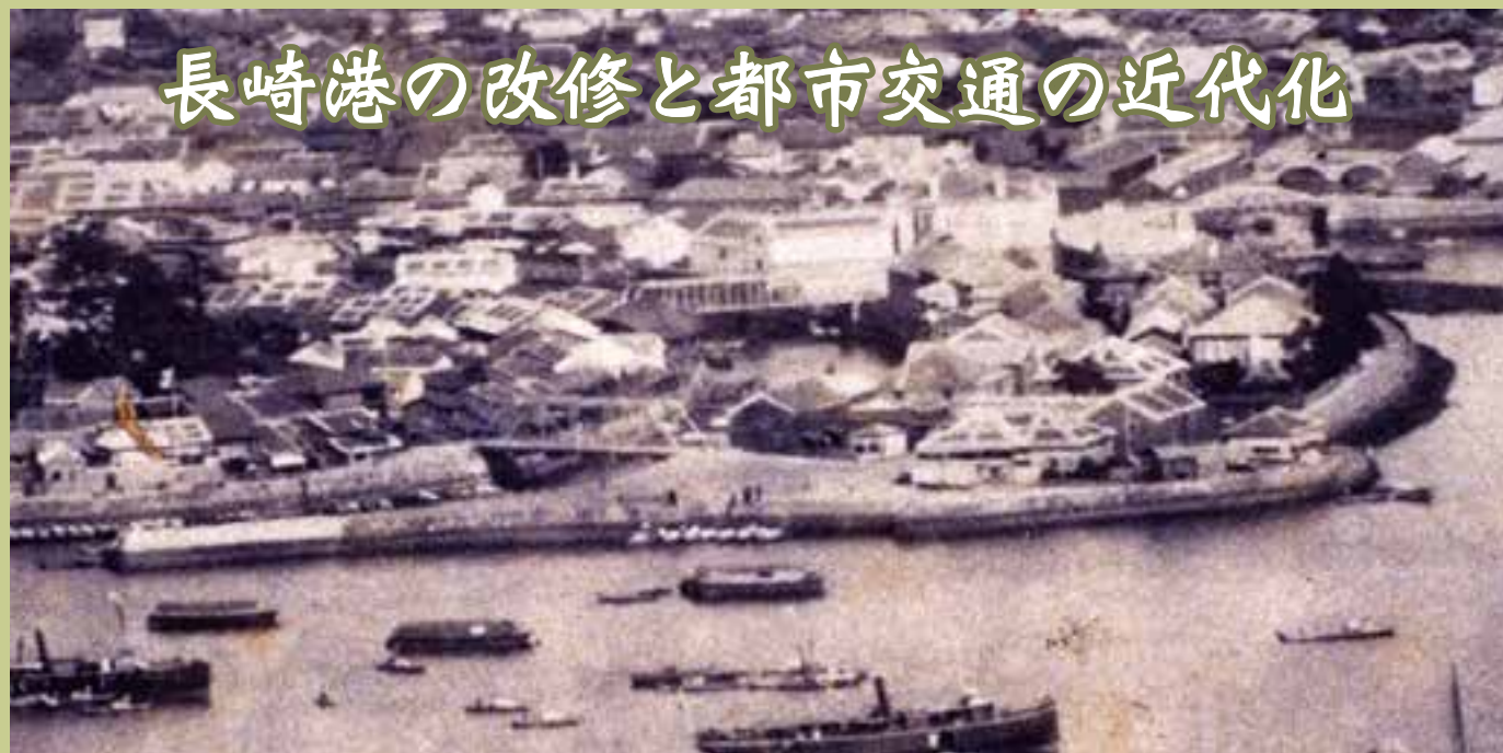
完成直後の中島川変流工事、中島川河口から見た写真。出島の先端に導流堤が見える。河口から最初の橋が新川口橋（鉄橋、明治23年（1890）架設）、次の橋が出島新橋（木鉄混交橋、明治22年（1889）架設）（長崎歴史文化博物館所蔵）
