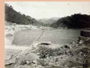
堰堤と濾過池(完成直後のダムと濾過池(後に新施設に更新)※
