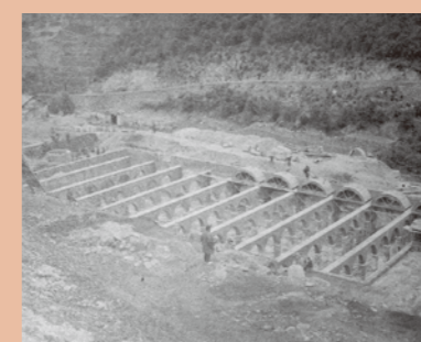
配水池(濾過した水を蓄積する半地下構造の配水池、現在でも使用)※
