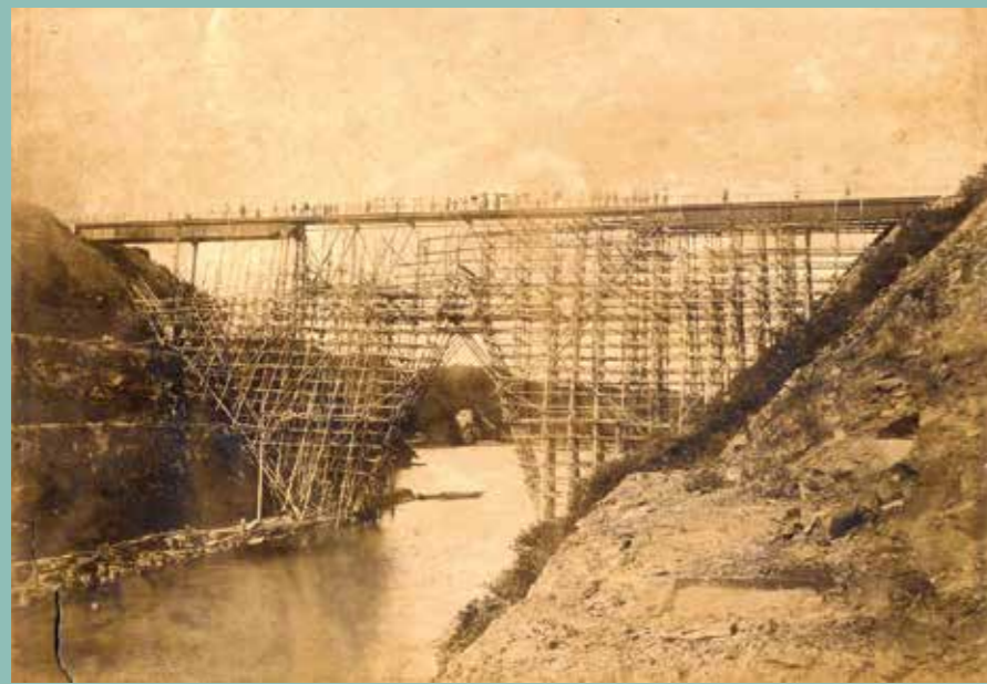
久須保水道(万関運河)**(明治33年(1900)から明治34年(1901))延長:300m、幅:22m、深さ:3m。久須保橋(明治34年(1901)8月23日完成)橋長:100m、幅員:2m、水上高さ36m。写真は久須保橋竣工記念のものである。
