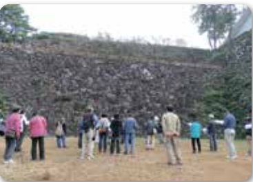
島原城の石垣(島原地区)
